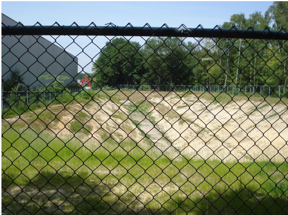
Foto 5a: Ingreeplocatie Retentiebekken Kaldenkerkerweg, Tegelen, 2009
